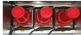
квадратные датчики не разборные. Крепление на бушинг при производстве ячеек
