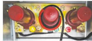
круглые датчики тока разборные, возможен монтаж на кабель и на бушинг
