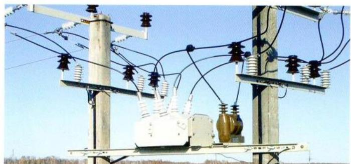
Рис. 4. Установка на ВЛ реклоузеров 6–10 кВ
